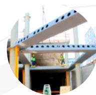
MARCOS DE ACERO DE CONSTRUCCIÓN
